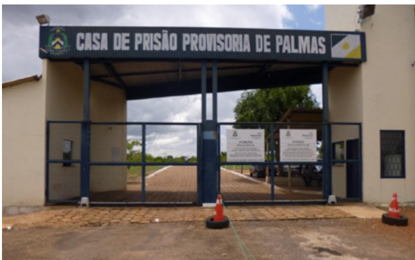
Ilustração 1 – Portão de acesso à CPP
