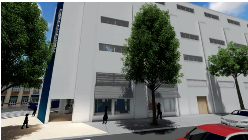
Figura 159 – Vista diurna do Hemonúcleo – destaque para os brises da fachada sul com sua arborização e acesso ao edifício
