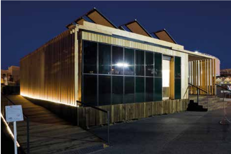
Figura 1: Protótipo no concurso Solar Decathlon Europe 2012: cobertura/BAPV, fachada /BIPV
