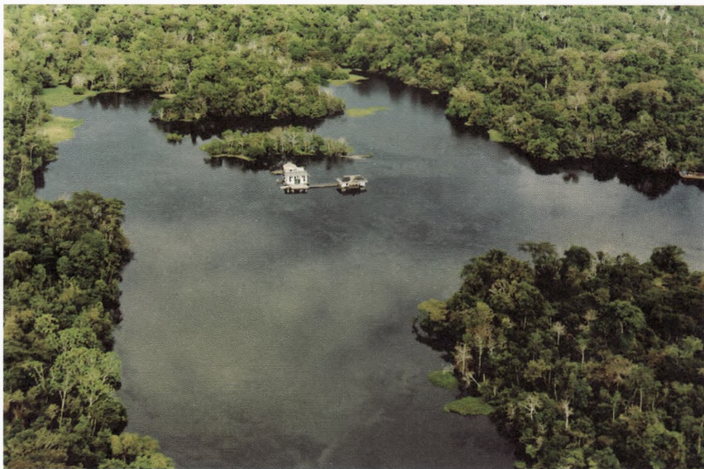
Vista aérea Pousada Uacari em construção, ano 2000 – programa de ecoturismo (Foto: Marco Bueno)
