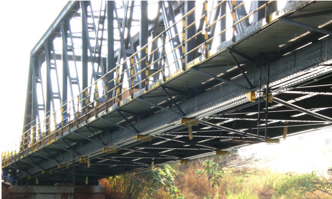
FIGURA 18: VISTA INFERIOR NA CONCLUSÃO DAS OBRAS— NOTAR PASSEIO E DISPOSITIVOS DE PROTENSÃO
