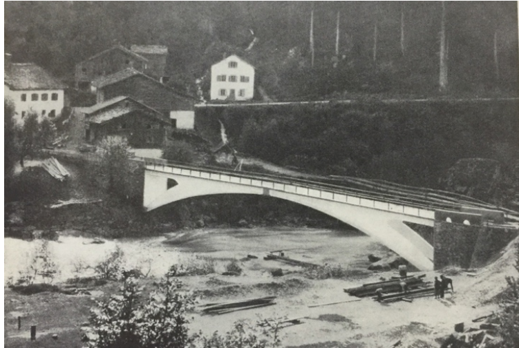
Figura 10: Ponte Tavanasa sobre o rio Reno
