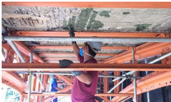
FIGURA 15: RECUPERAÇÃO DA PARTE INFERIOR DA LAJE
