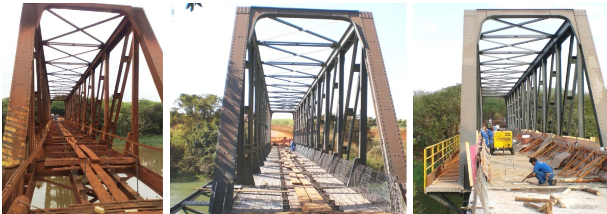
FIGURA 13: VISTA TRANSVERSAL EM TRÊS FASES DA RECUPERAÇÃO – NOTAR PRÉ-LAJES E PASSEIO
