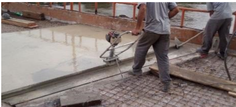
FIGURA 17: REFORÇO DA LAJE
