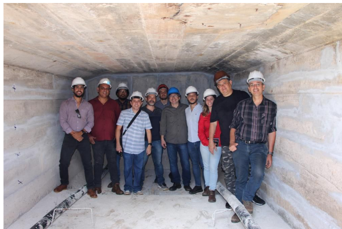
Figura 14: Vista interna da laje caixão
