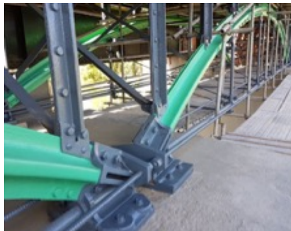
FIGURA 26: VÃOS EM ARCO REFORÇADO
