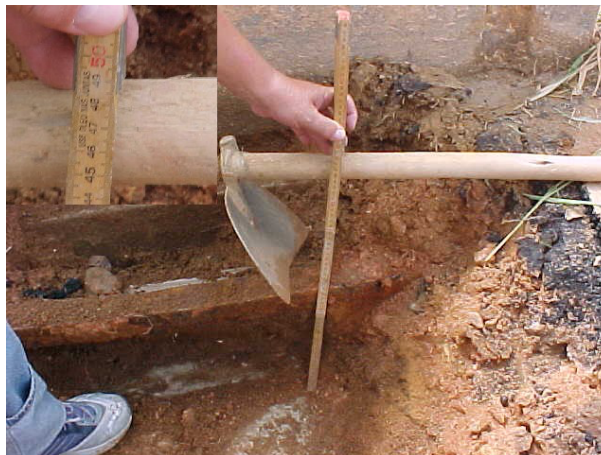
FIGURA 5. MEDIÇÃO DA CAMADA NO TABULEIRO DA PONTE
