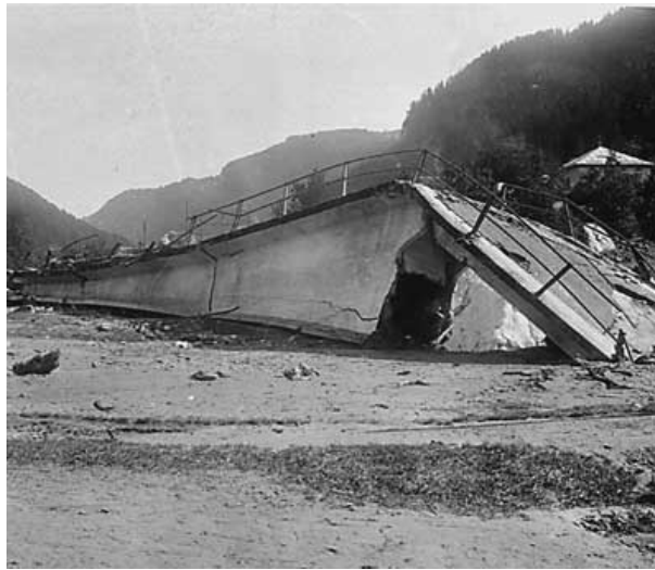
Figura 7: Ponte Tavanassa em ruínas após avalanche de pedras
