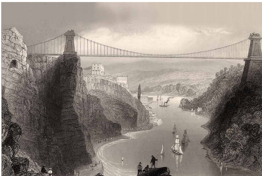
FIGURA 1: PONTE PÊNSIL DE CLIFTON EM BRISTOL, PROJETADA POR BRUNEL
