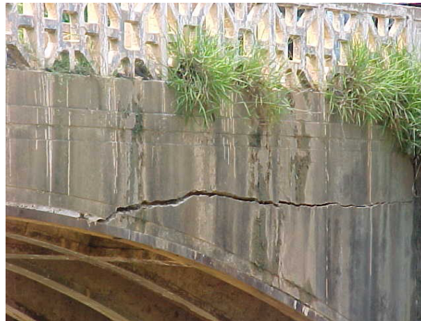
FIGURA. VISTA DA PONTE NO LADO DO RECALQUE
