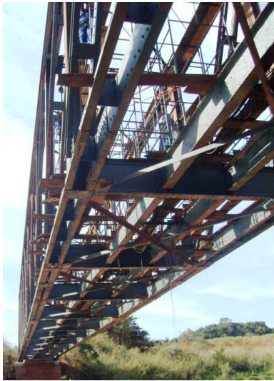
Figura 15: Vista inferior durante a recuperação – notar estrutura metálica do passeio
