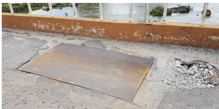
FIGURA 16: SUPERFÍCIE SUPERIOR DA LAJE
