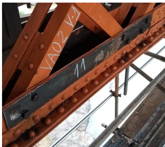
FIGURA 21: RECUPERAÇÃO DAS CONEXÕES DAS DIAGONAIS
