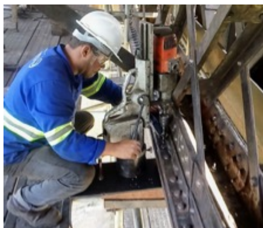
FIGURA 29: REMOÇÃO DOS REBITES
