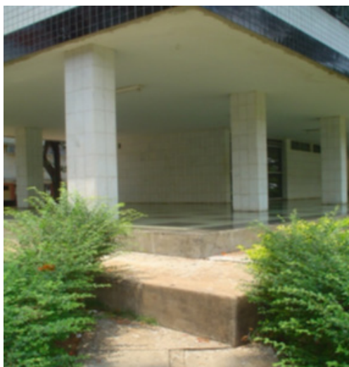
Figura 4. Pilotis ocupados e acessibilidade restrita na 202 e 402 Norte. Fonte: A autora
