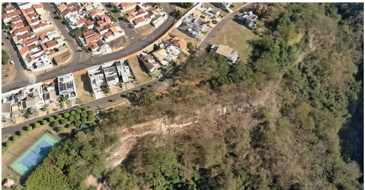
Figura 7. Moradias do Condomínio Garden Park próximas à linha de ruptura do relevo.
