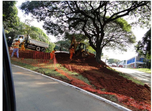
Figura 6. Obra em andamento. 1ª etapa no viaduto 201/202 Norte, em maio
