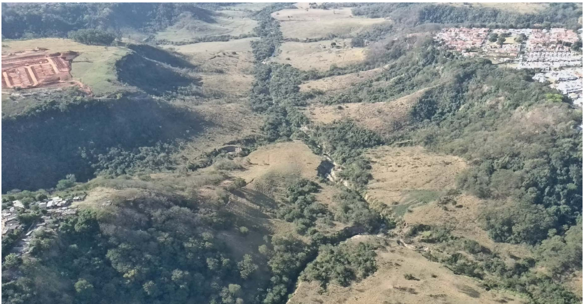
Figura 8. Sinais de abatimento de terreno e de formação de sulcos no vale do córrego Palmital, ocupado de ambos os lados.
