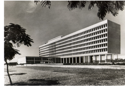
Figura 1 – Foto mostrando perspectiva externa do edifício-sede da FNA na Cidade Universitária do Rio de Janeiro.
