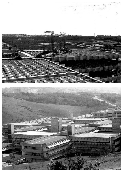
Figura 4 - ICB em construção.
