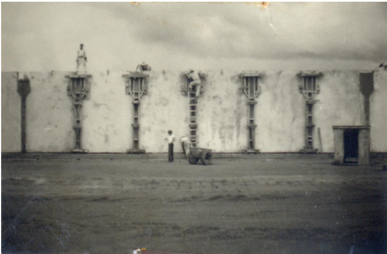
Figura 17 - Vista do subsolo. Moldagem no local de suportes em forma de cálice.
