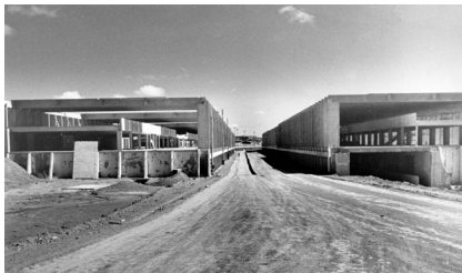
Figuras 18 - Vista da montagem das peças pré-fabricadas. ICC.
