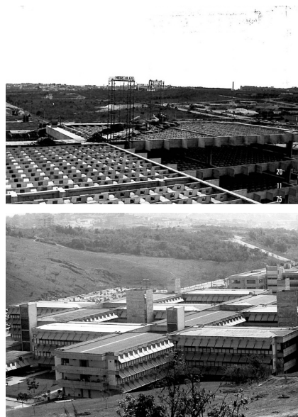
Figura 4 - ICB em construção.
