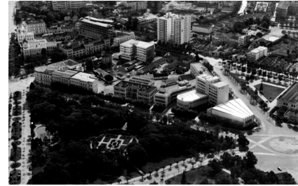
Figura 7 - UFRGS, Campus Centro, Quarteirão 2, conformado pelas Avenidas Osvaldo Aranha, Paulo Gama, Engenheiro Luiz Englert e Rua Sarmiento Leite. Vértices configurados pela Faculdade de Medicina (1913), Auditório da Reitoria (1954 - reformado posteriormente) e Faculdade de Arquitetura (1957).
