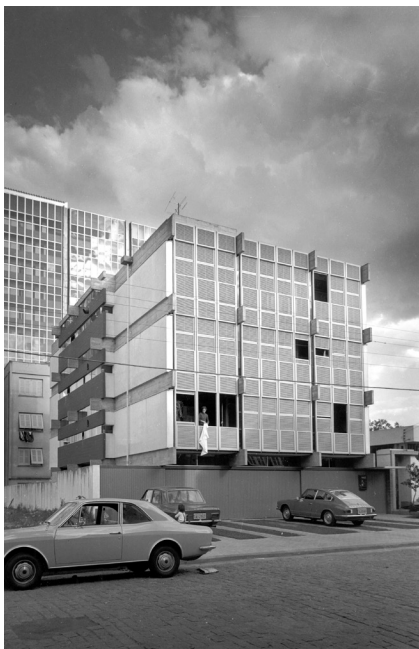
Figura 13 - Edifício FAM. Arquitetura representativa de certa maneira de fazer Arquitetura Moderna, Brasileira no Sul. Carlos Maximiliano Fayet, Cláudio L. G. Araújo e Moacyr Moojen Marques, 1966/1968.
