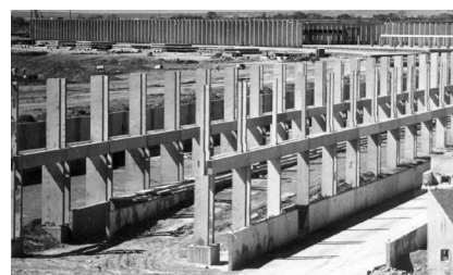
Figura 13 - Construção de radier. ICC. Fonte: Arquivo UnB
