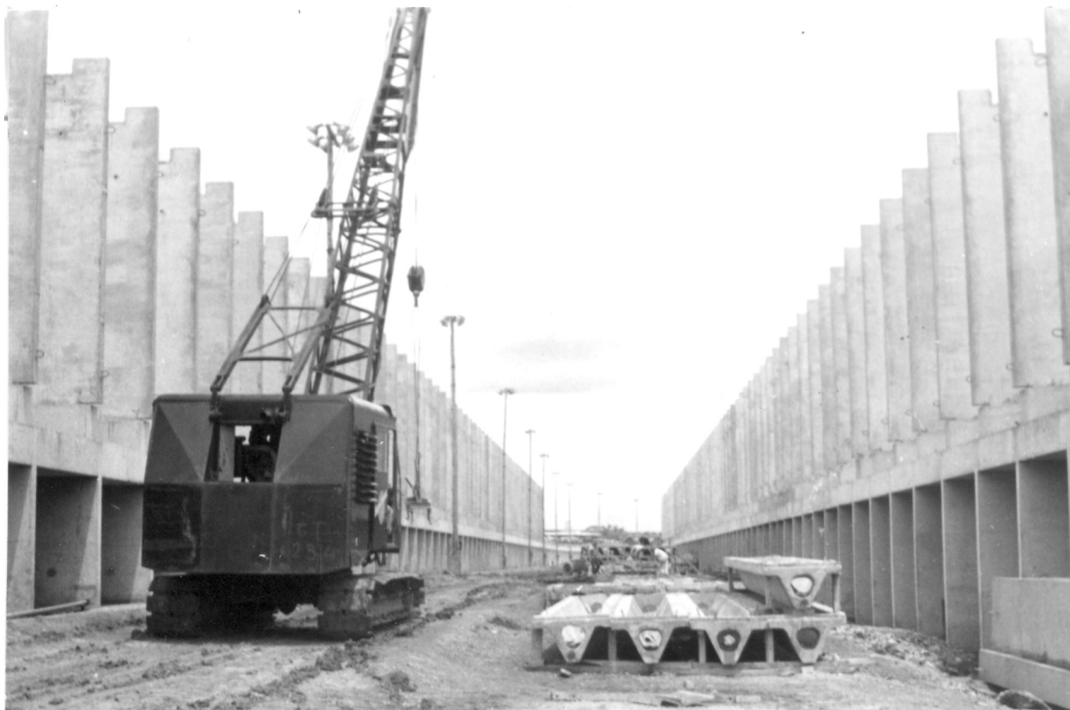
Figura 18 – Vista interna da montagem do Bloco C.
