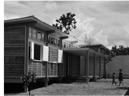
Figura 5 - Vista frontal de residências para canteiros em Brasília.
