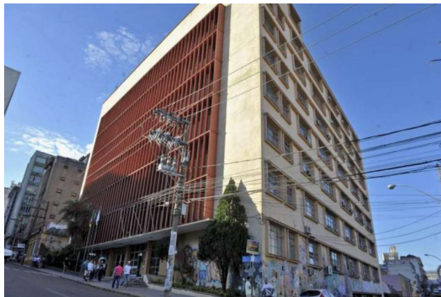
Figura 1 – Prédio conhecido como Antiga Reitoria [8].
