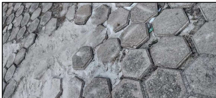
Figura 5 - Pavimento da praça pública em concreto intertravado
