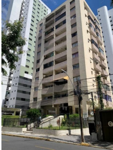
Figura 4 – Vista frontal da edificação em estudo
