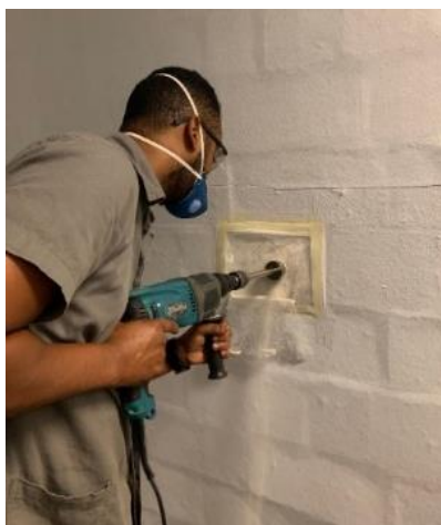
Figura 2 – Equipamento de corte utilizado para extração de amostras de revestimento.
