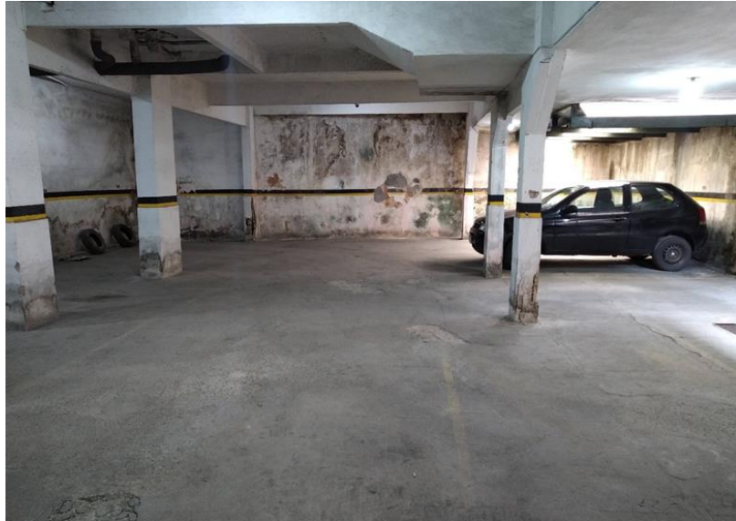
Figura 4 - Vista da garagem do edifício
