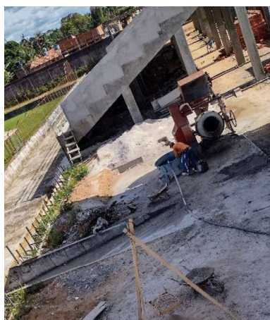
Figura 5 - Fábrica de concreto e parte do canteiro de obra
