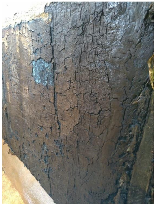
Figura 7 – Manta asfáltica da lateral do reservatório.
