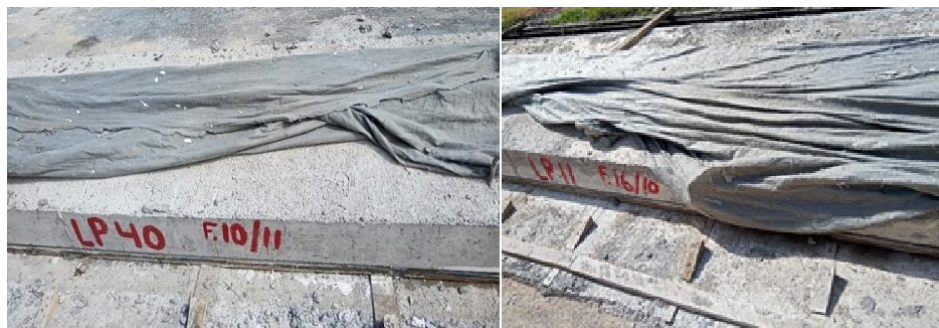
Figura 4 - Cura com mantas sem umedecimento, em elementos pré-moldado.
