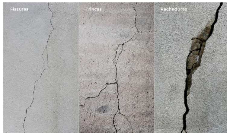
Figura 1 – Comparativo entre fissuras, trincas e rachaduras [8]
