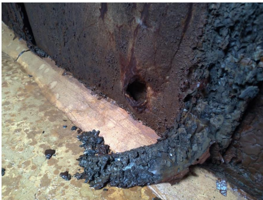
Figura 9 – Detalhes da manta asfáltica do reservatório.
