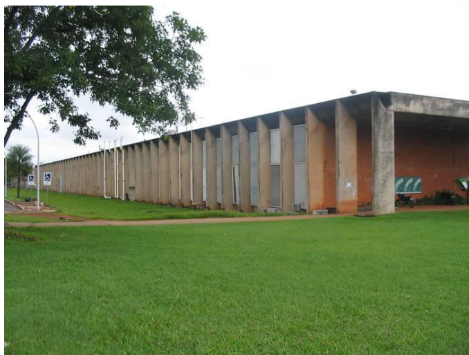
Figura 13 – Instituto Central de Ciências – ICC, Universidade de Brasília – UnB
