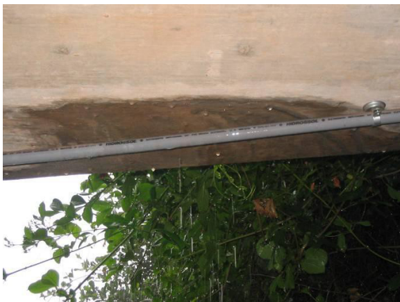
Figura 16 – Escoamento de água da chuva sobre superfície de concreto. Laje mezanino – ICC Ala Norte
