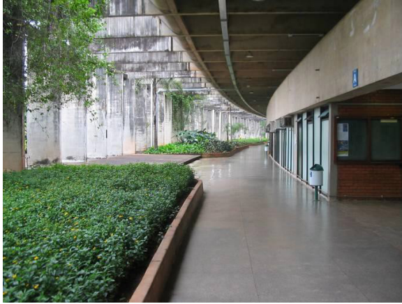
Figura 14 – Vista interna do ICC – Ala Centro
