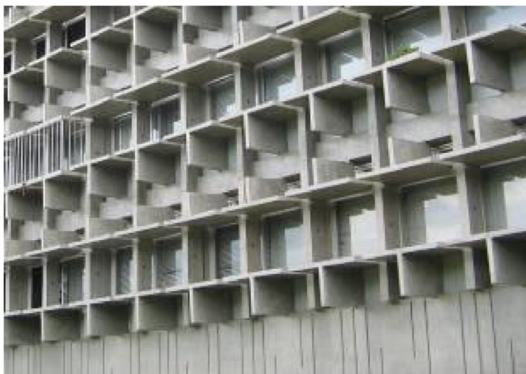
Figura 11 – Exemplo de brise misto do edifício residencial da Superquadra SQN 206 do Plano Piloto de Brasília
