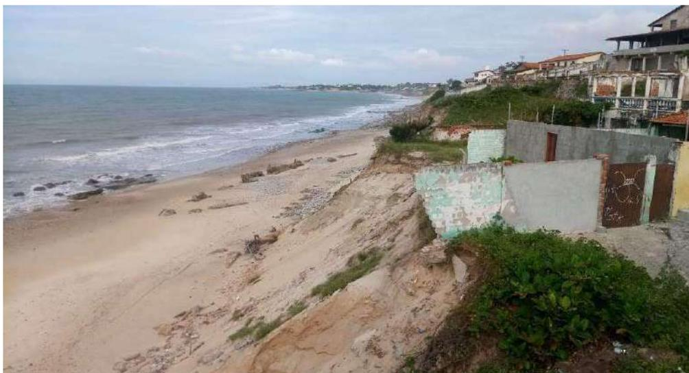
**Figura 10.** Destruição de imóveis ocasionada pela erosão na praia do Icaraí, uma das mais afetadas da orla do município de Caucaia. Uma área de risco à população local. Fonte: Os autores.
