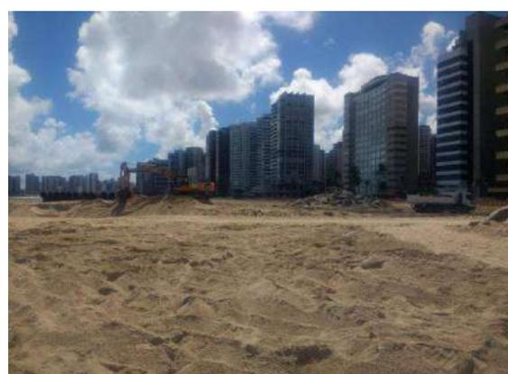
**Figura 15.** Aterro hidráulico da Praia de Iracema e obras para a construção de novo aterro da Avenida Beira-Mar em Fortaleza. Fonte: Os autores.
