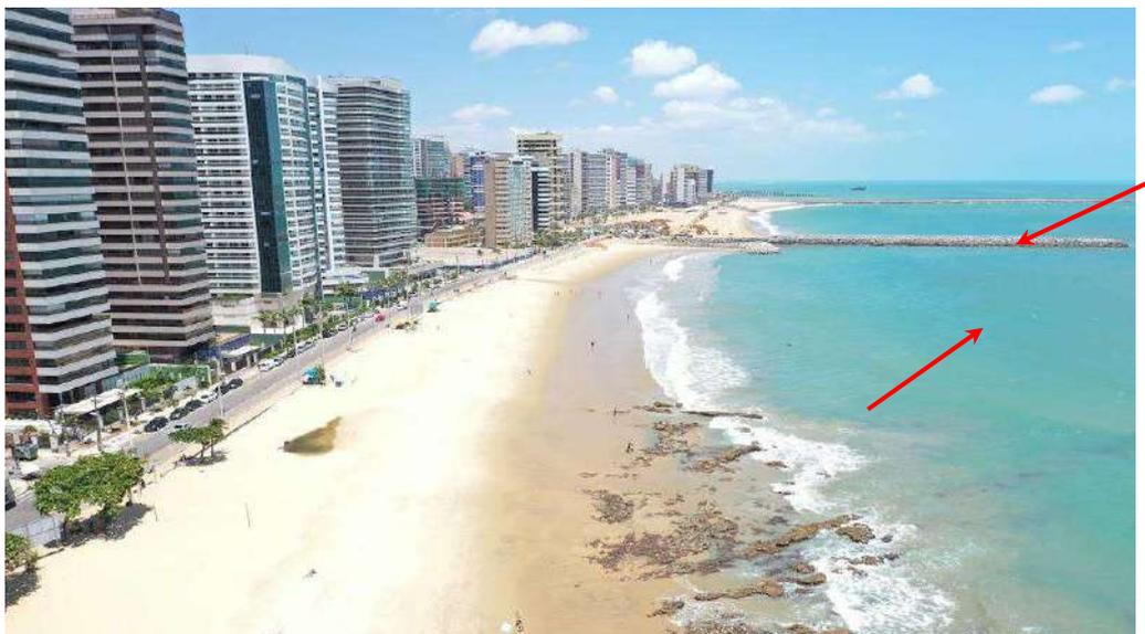
**Figura 9.** Os molhes (indicados pelas setas vermelhas) construídos na orla de Fortaleza foram instalados para contenção da erosão originada a partir da construção do Porto do Mucuripe. Promovem o acúmulo sedimentar à montante, além de garantir a estabilidade morfológica do aterro hidráulico da Praia de Iracema. Fonte: Os autores.
