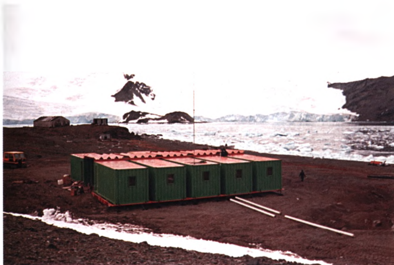
Figura 5: Estação quase pronta. Ao fundo, as construções inglesas abandonadas
