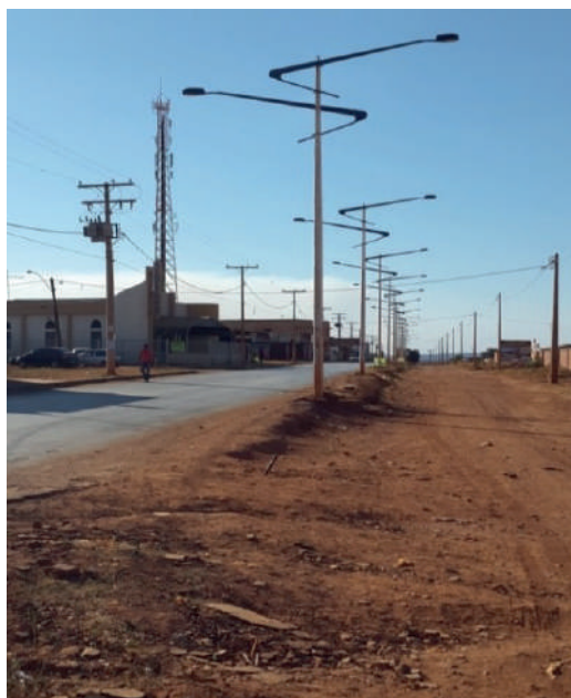
Figura 5.1: Entrada do bairro Cidade do Entorno (2013)
