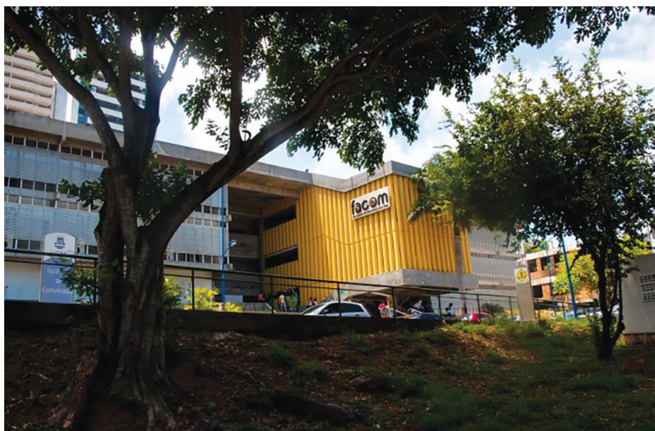
Figura 1. Fachada do Prédio da Faculdade de Comunicação no Campus de Ondina
