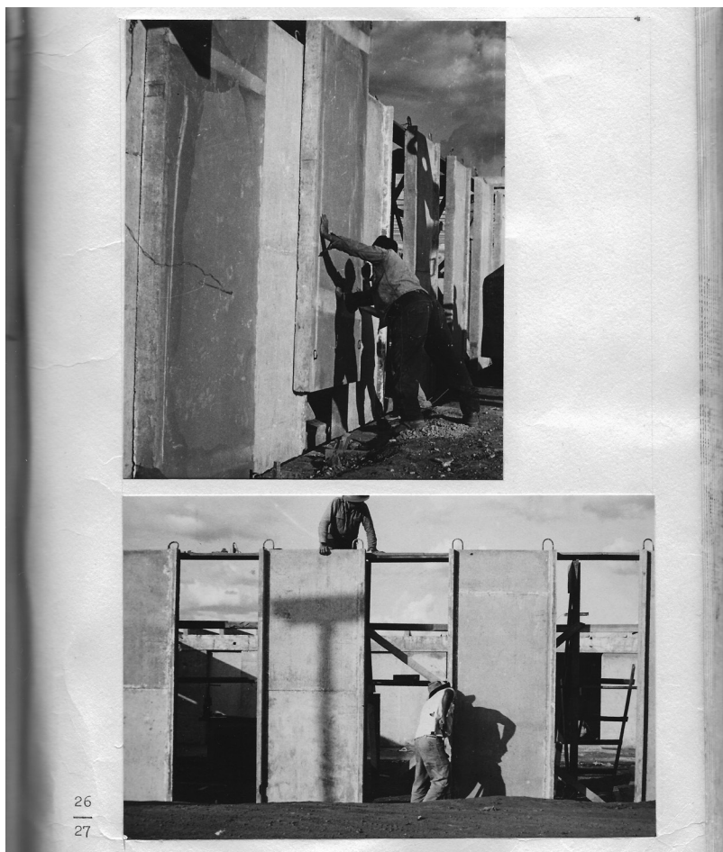
Figura 19: Construção do edifício de Serviços Gerais
