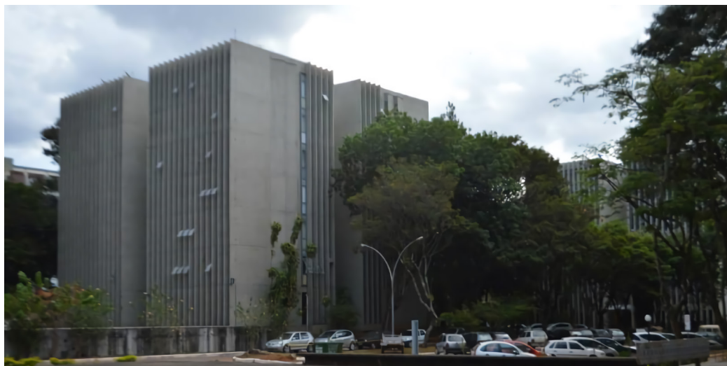
Figura 41: Os bloquinhos construídos
