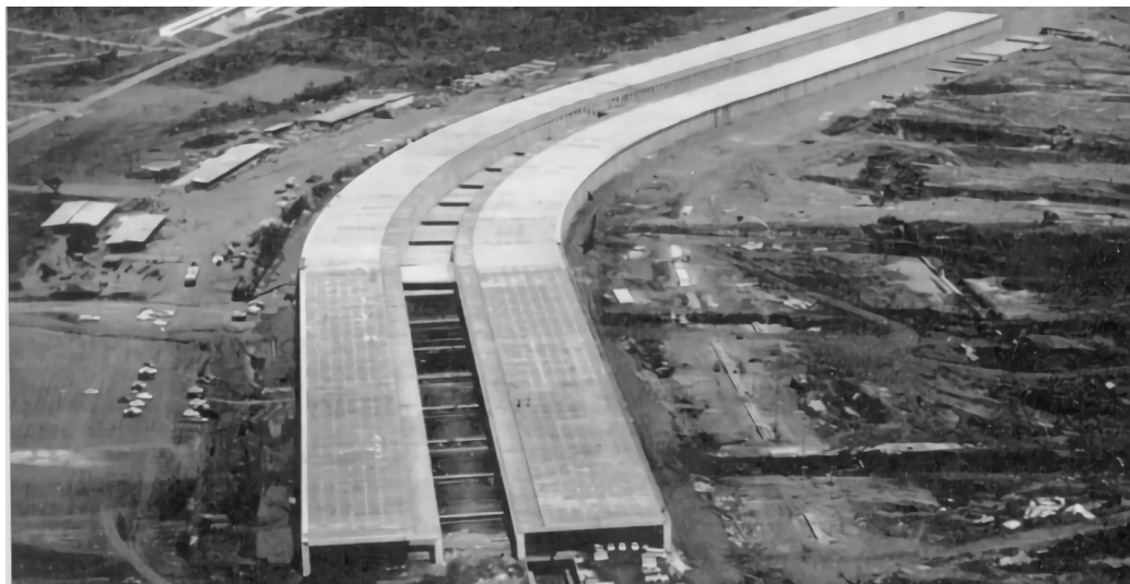
Figura 15: Instituto Central de Artes em construção
