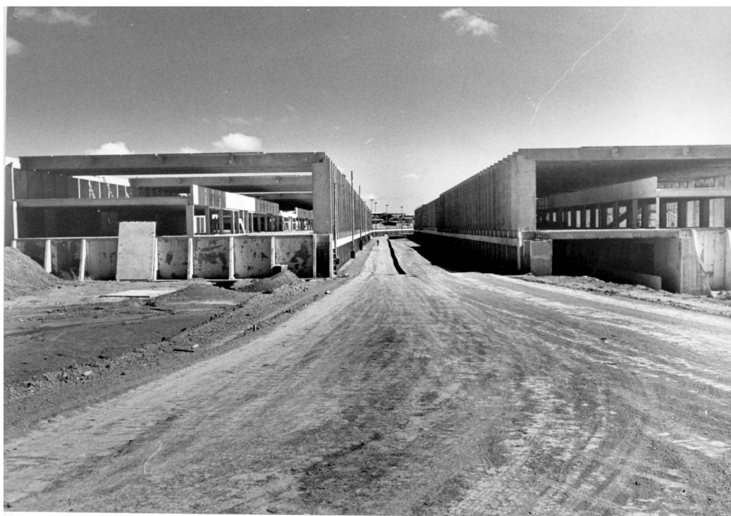
Figura 14: Instituto Central de Artes em obras
