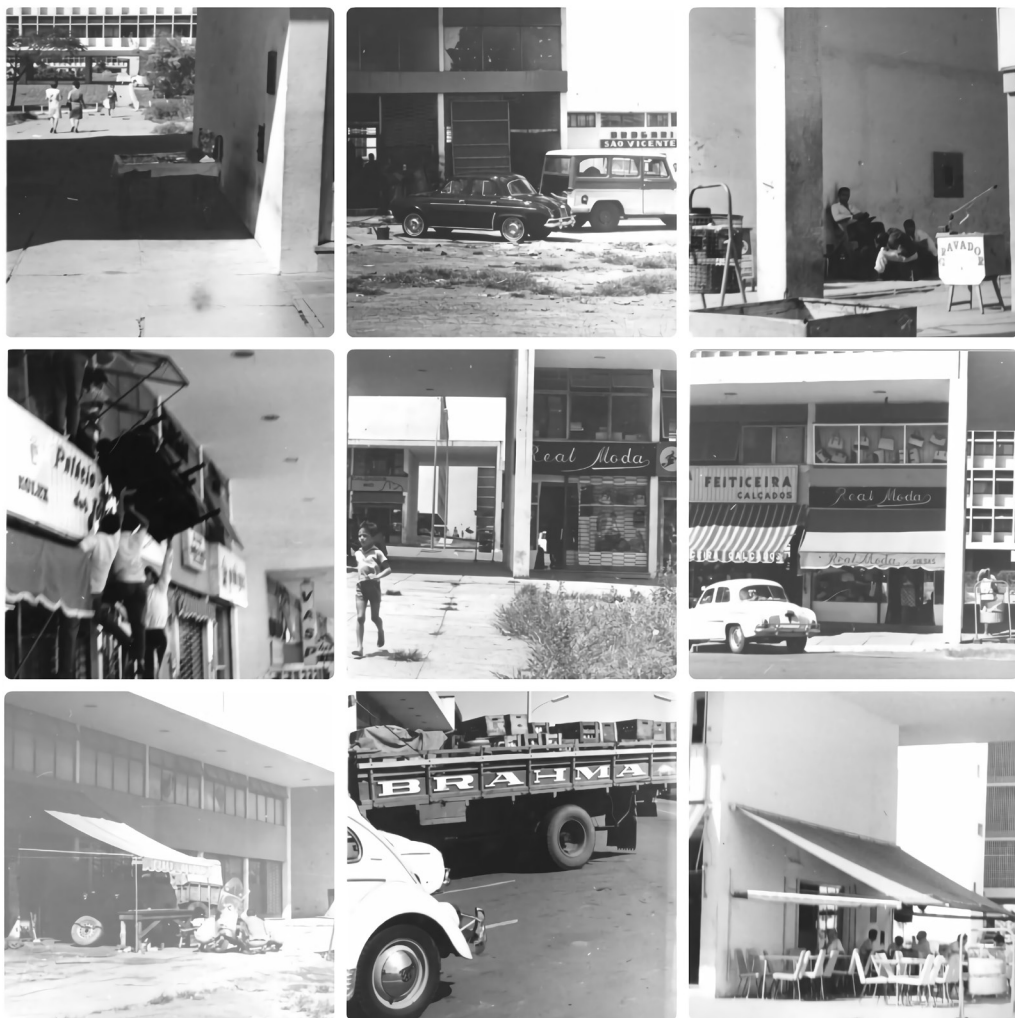
Figura 38: Montagem – fotos do comércio
