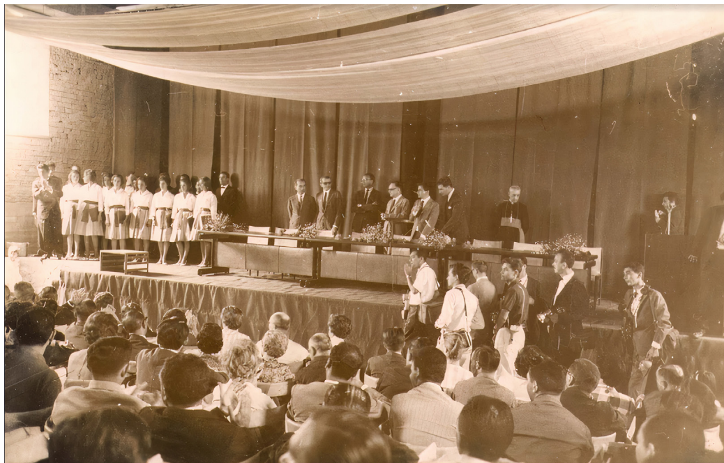
Figura 7: Inauguração da Universidade de Brasília – Auditório Dois Candangos em construção
