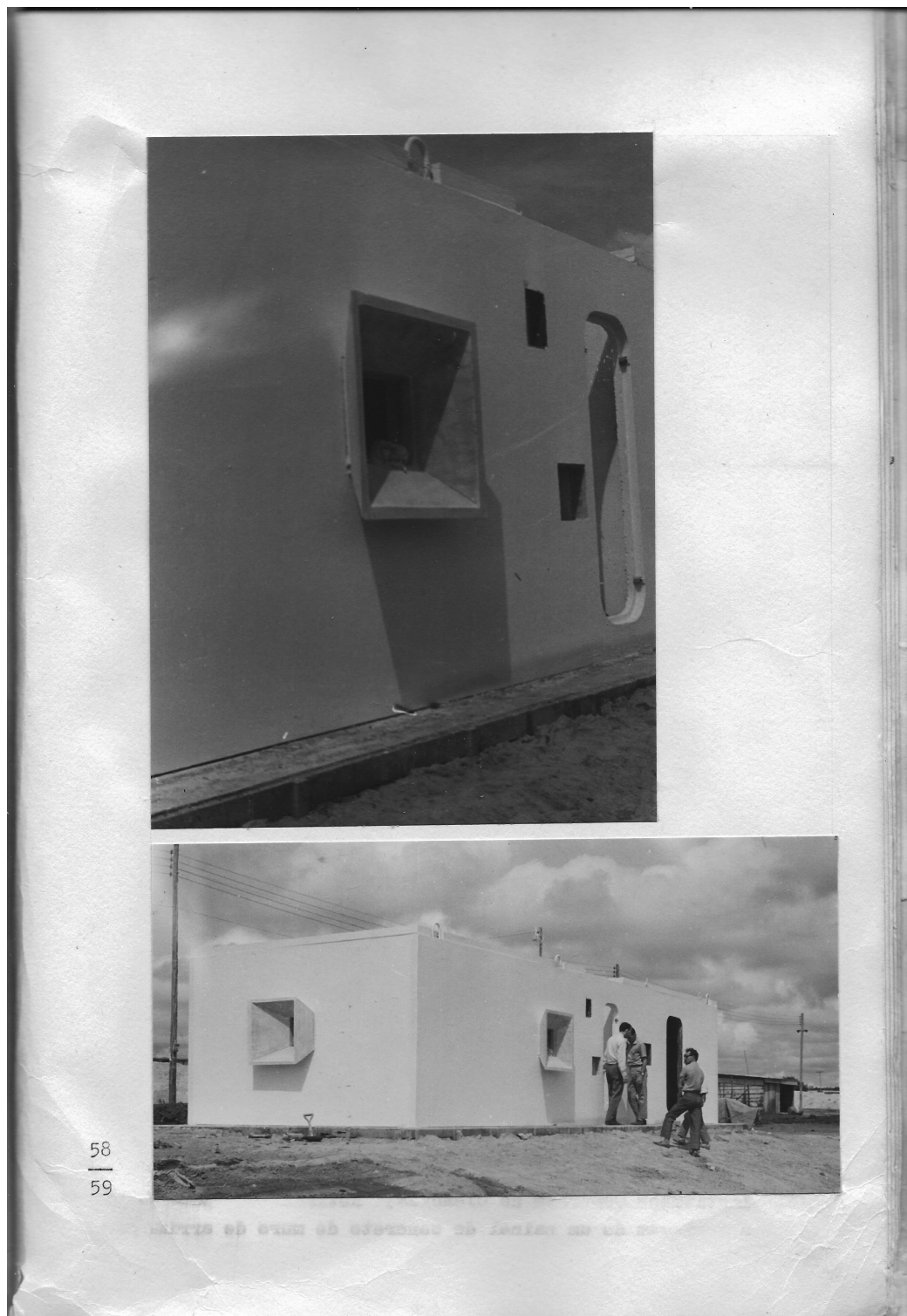
Figura 20: Construção do Protótipo Residencial
