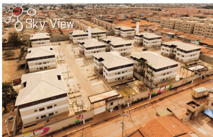
Figura 6.13 – Vista Panorâmica de condomínio pronto
