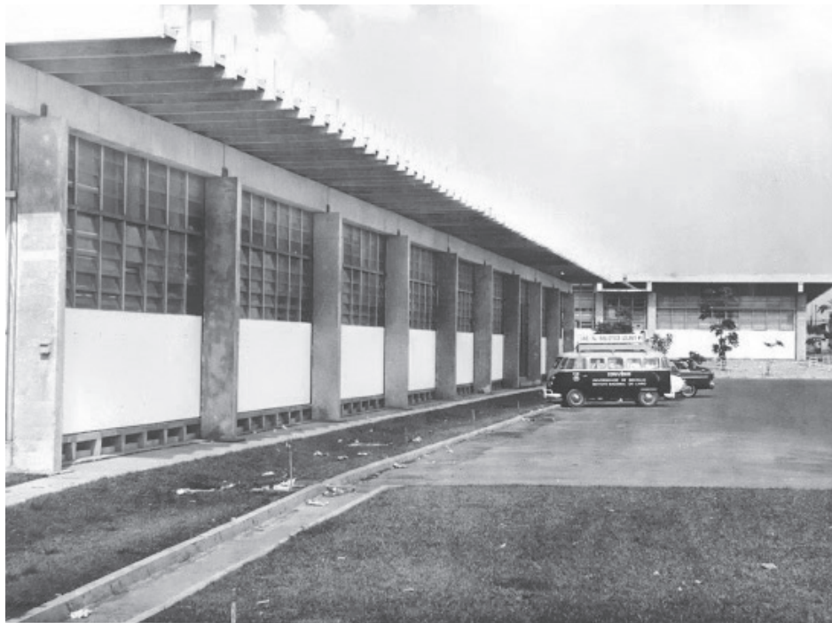
Biblioteca Central na SG-12 com a Biblioteca Volante ao fundo (1963).
