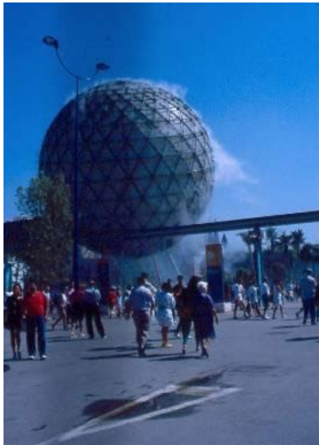
Figura 15 - EXPO92. Nuvem de água produzida através de 1340 micronizadores instalados numa esfera 22m. de diâmetro. Evapora 10m 3 /hora de água. Fonte: Da autora.
