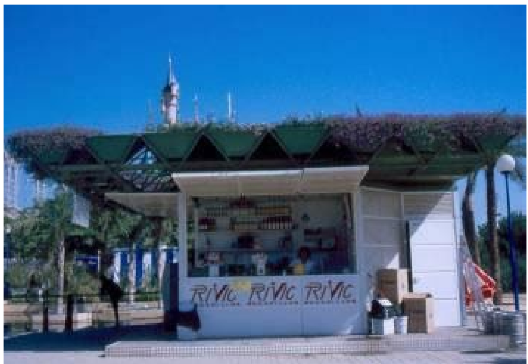
Figura 19 - Quiosque com cobertura de pérgulas vegetais de cultivo hidropônico. Fonte: Da autora.
