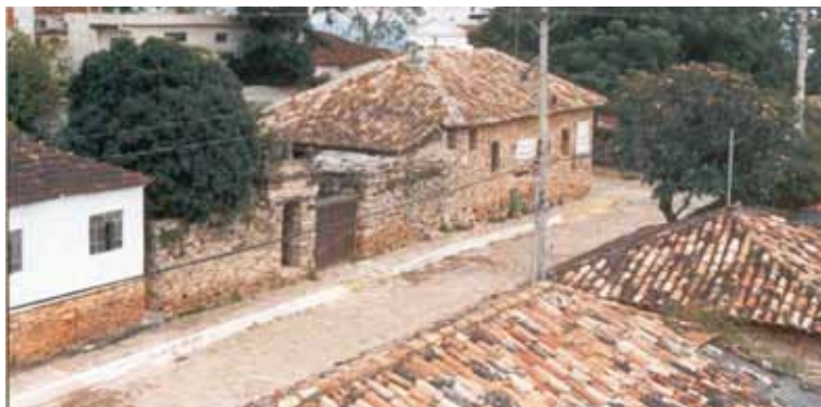
Figura 3 - Casa típica construída toda em pedra, bem como as ruas e calçadas. As telhas são artesanais, confeccionadas na cidade.
