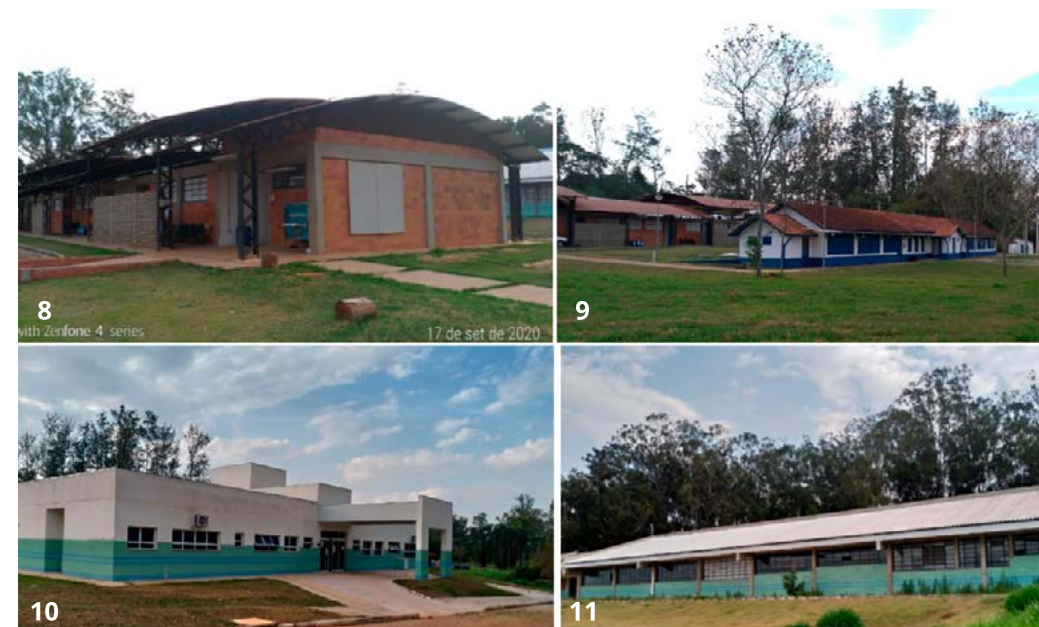
Figuras 8 a 11. Antiga garagem transformada em bloco de salas de aula; Edificações existentes adaptadas - Biblioteca; Ambulatório; Bloco Didático 2 Fonte. Os Autores (2020).
