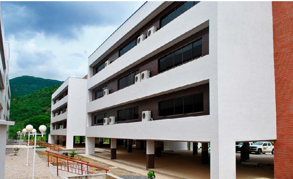
Figura 3. Vista parcial de um dos edifícios da Unidade Acadêmica dos Palmares em Acarape/CE
