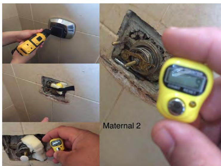
**Figura 4.** Instalação de contadores analógicos em válvula de descarga
