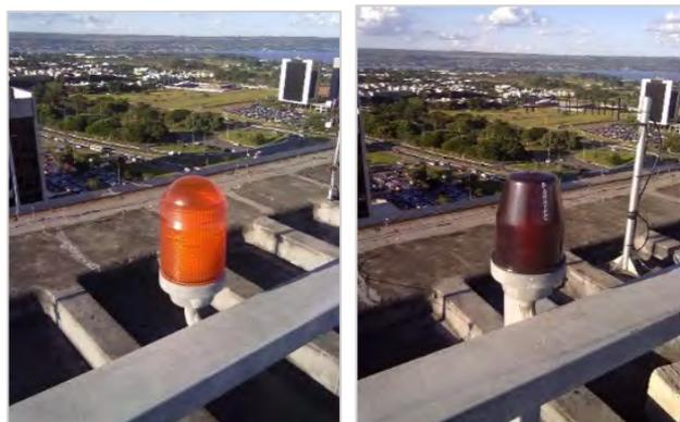
**Figuras 12 e 13** – Uso simultâneo irregular de globo prismático em borossilicato padrão e filtro SN06
