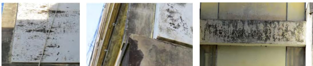
**Figura 26** – Manchas | **Figura 27** – Manchas | **Figura 28** – Eflorescência. Fonte: Acervo do Autor
