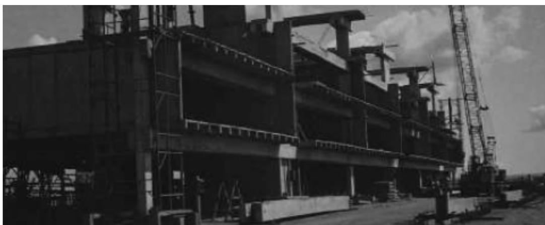
**Figura 13** – Início da montagem do terceiro pavimento. Destaque para os painéis da empena, preenchem o vazio do esqueleto. Fonte: PESSINA, 1964
