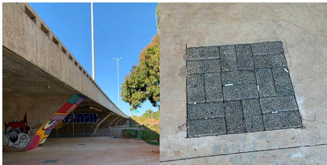
**Figura 18.** Ponto de escoamento em pavimentação drenante, concreto permeável, Viaduto sobre a Galeria dos Estados, Brasília, DF (Fonte: autoral)
