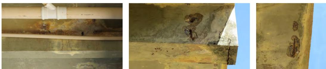
**Figura 32** – Eflorescência | **Figura 33** – Desagregação | **Figura 34** – Corrosão. Fonte: Acervo do Autor
