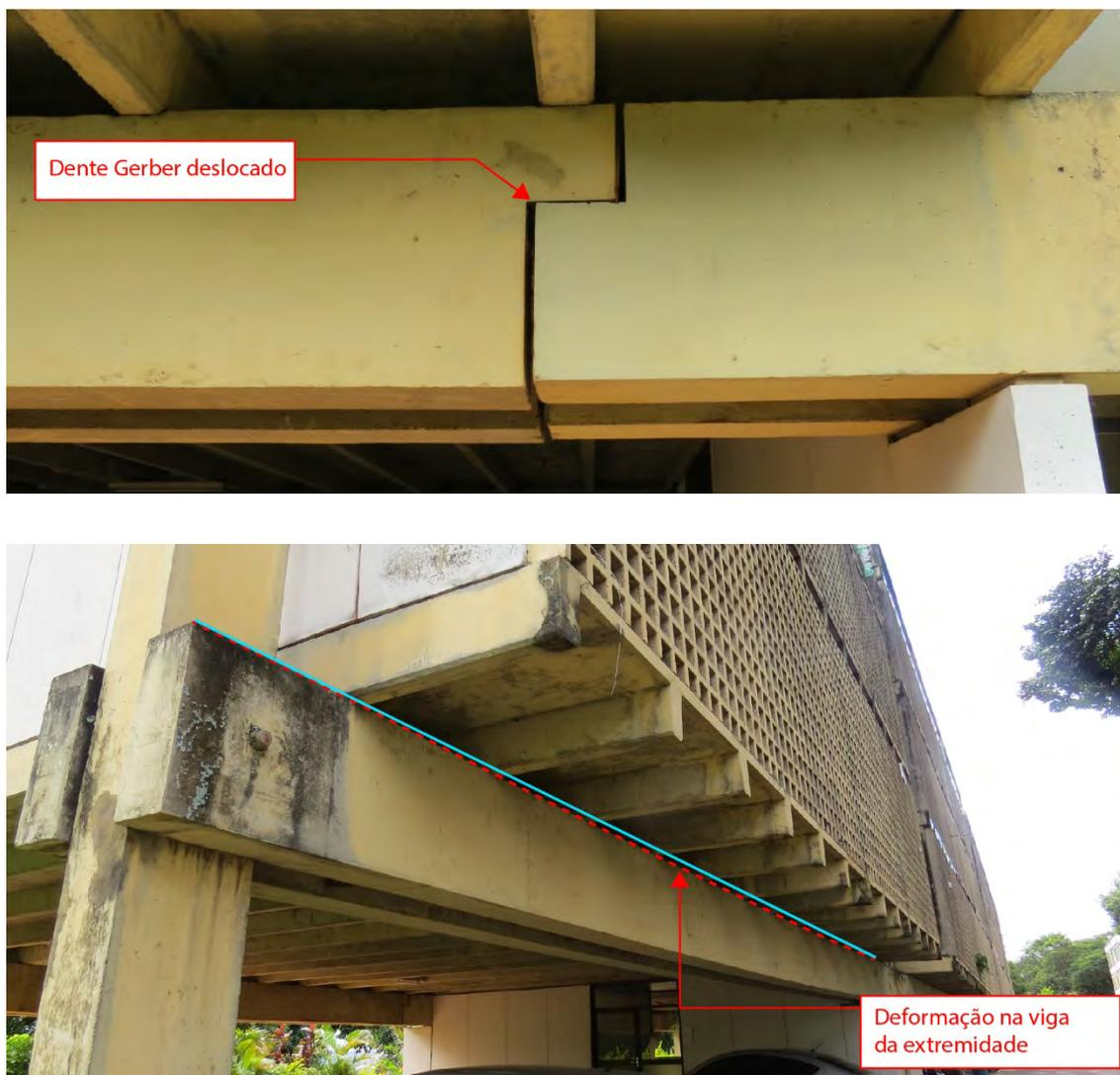
**Figura 25**– Inspeção visual. Deslocamento na viga da extremidade. Fonte: Acervo do autor
