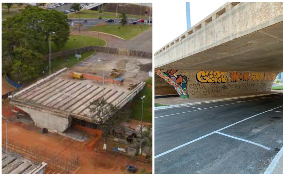
**Figura 14 – 15.** Pilar em situação de ruína parcial após desabamento e pilar após Retrofit estrutural, Viaduto sobre a Galeria dos Estados, Brasília, DF (Fonte: autoral)
