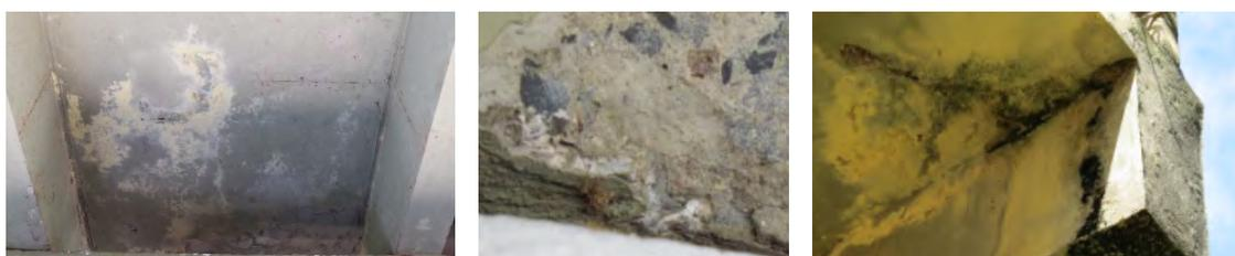
**Figura 29** – Eflorescência | **Figura 30** – Desagregação | **Figura 31** – Fissuras. Fonte: Acervo do Autor
