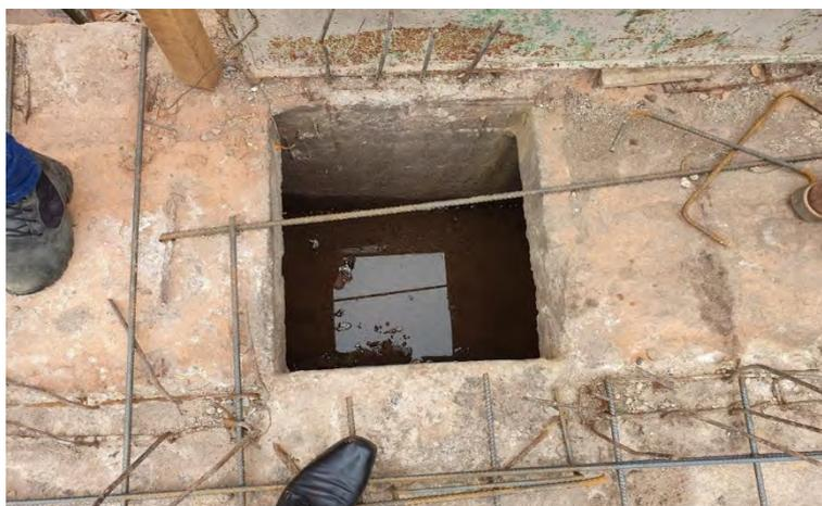
**Modelo estrutural que não permitia inspeções:** A estrutura não possuía acesso fácil de inspeções regulares, assim como não possuía instrumentos de controle de qualidade e ou de apresentação de possíveis patologias. Notar na figura 5 que o tabuleiro era fechado por laje, logo não se podia inspecionar as vigotas, transversinas e a própria laje.
