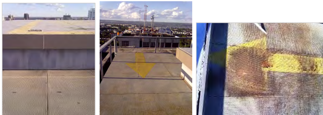
Figuras 7, 8 e 9 – Diferença de altura da FATO para a TLOF e estado precário de manutenção da FATO
