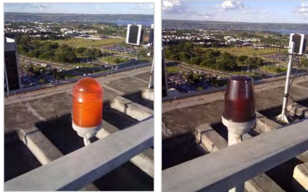
Figuras 12 e 13 – Uso simultâneo irregular de globo prismático em borossilicato padrão e filtro SN06
