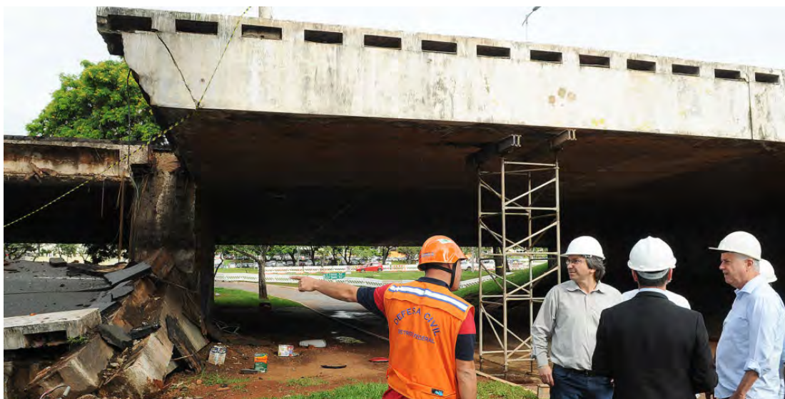
Figura 7. Trecho do tabuleiro em ruína e área externa antes do Retrofit, Viaduto sobre a Galeria dos Estados, Brasília, DF (Fonte: Tony Winston/Agência Brasília)
