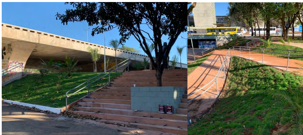
Figura 19 – 20. Escadas e rampas respeitando a NBR 9050, após Retrofit URBANO, Viaduto sobre a Galeria dos Estados, Brasília, DF (Fonte: autoral)
