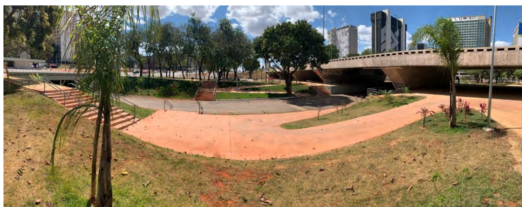
Figura 23 Escadas e rampas respeitando a NBR 9050, após Retrofit URBANO, Viaduto sobre a Galeria dos Estados, Brasília, DF (Fonte: autoral)
