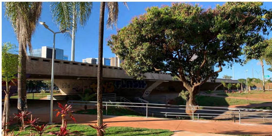
Figura 4. Pilares em formato “asa delta”, Viaduto sobre a Galeria dos Estados, Brasília, DF (Fonte: autoral)
