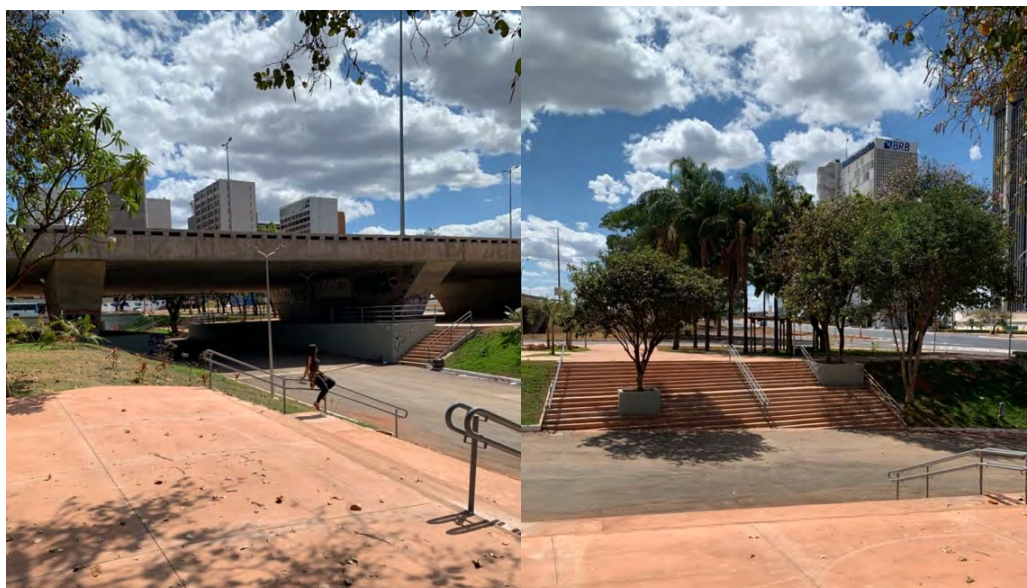
Figura 21 – 22. Escadas e rampas respeitando a NBR 9050, após Retrofit URBANO, Viaduto sobre a Galeria dos Estados, Brasília, DF (Fonte: autoral)
