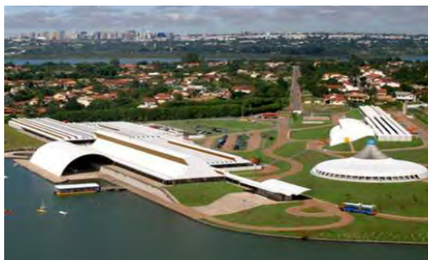
Figuras 4: Vista aérea dos edifícios do hospital Sarah Lago Norte.
