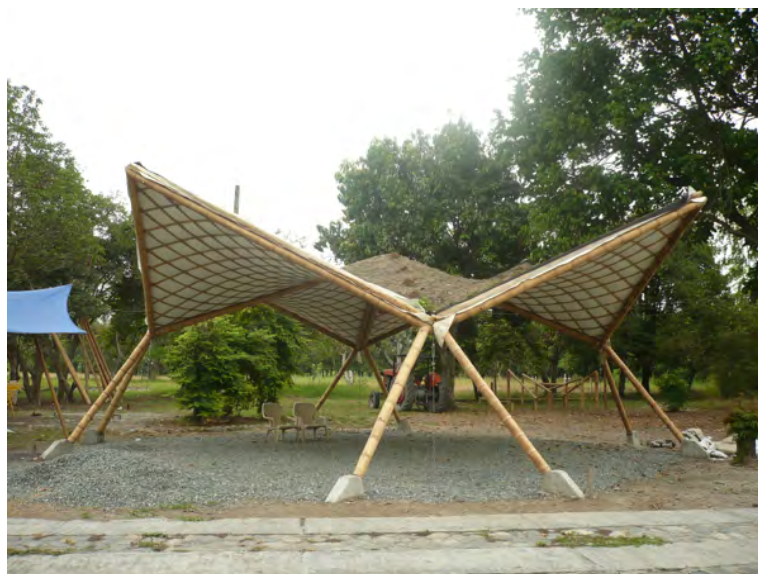
Figura 5: Estrutura em bambu utilizada para o presente estudo de caso. Fonte: Minke, 2016.
