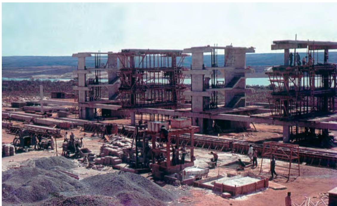
Figura 9 – Construção do Bloco A do conjunto arquitetônico da Colina. Destaque para a produção das vigas no canteiro Fonte: UnB Agência
