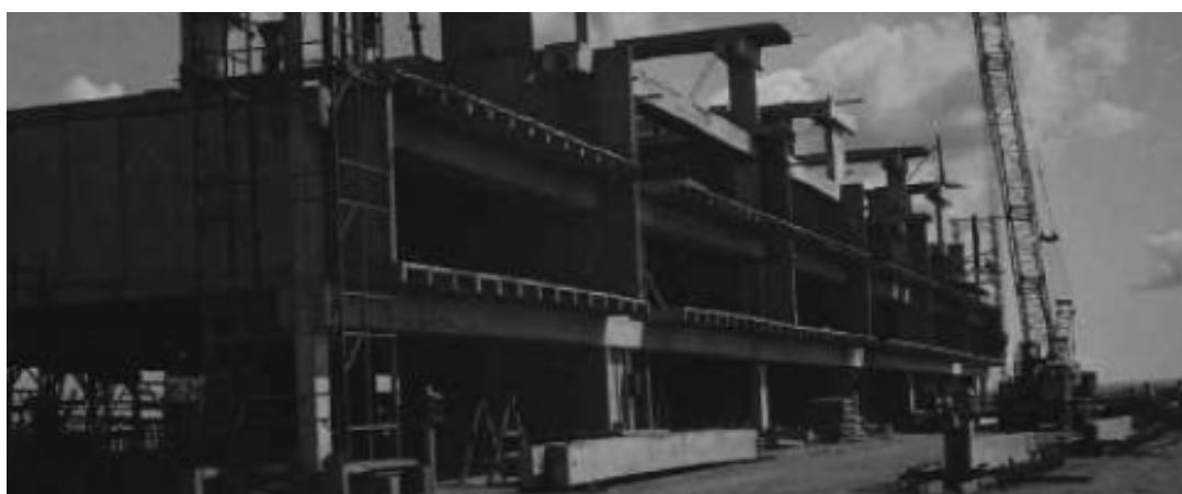
Figura 13 – Início da montagem do terceiro pavimento. Destaque para os painéis da empena, preenchem o vazio do esqueleto. Fonte: PESSINA, 1964
