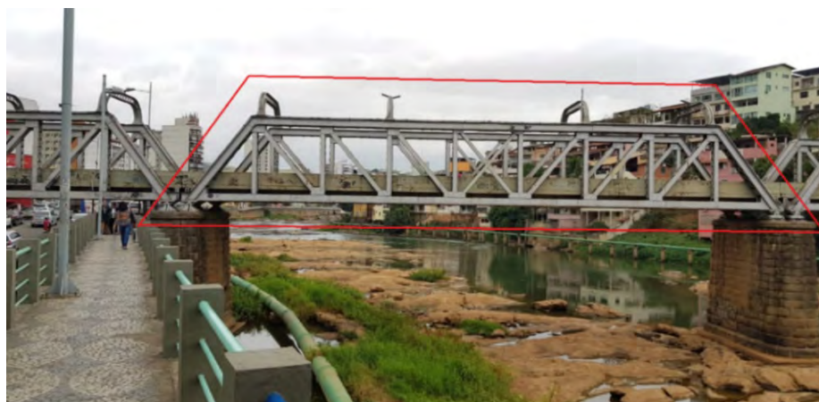
Figura 10: Trecho inspecionado da Ponte de Ferro.
