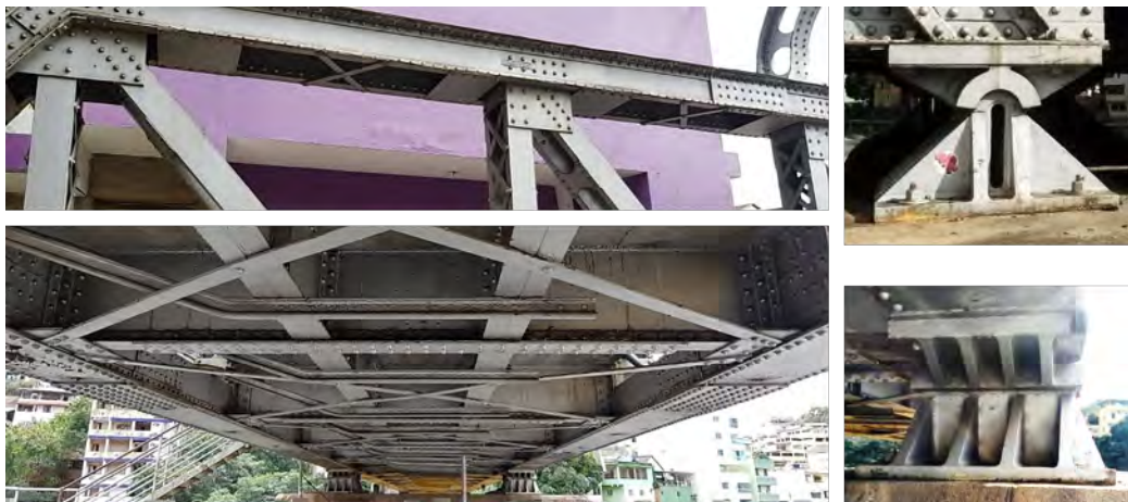
Figura 5: Vista lateral e inferior da estrutura da Ponte de Ferro e dos aparelhos de apoio.
