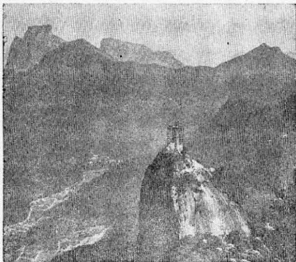
Vista aérea do Corcovado, com o monumento ao Cristo Redentor em construção (1931).
