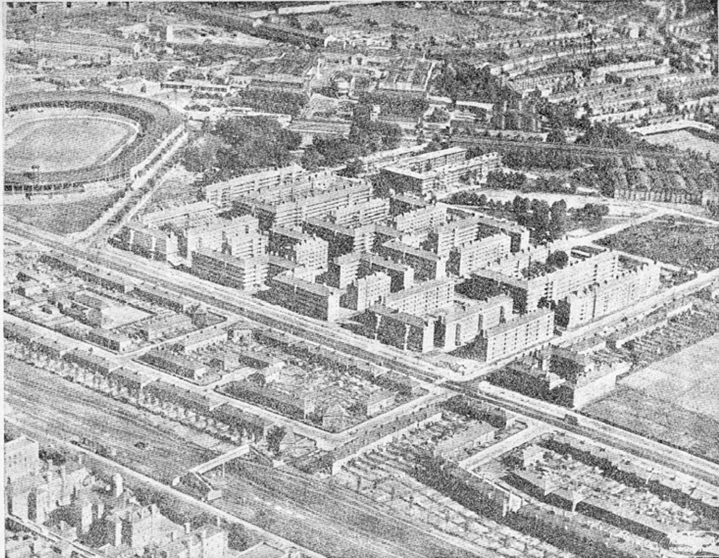
Fig. 70 — Vista aérea do conjunto residencial de Hammersmith.
