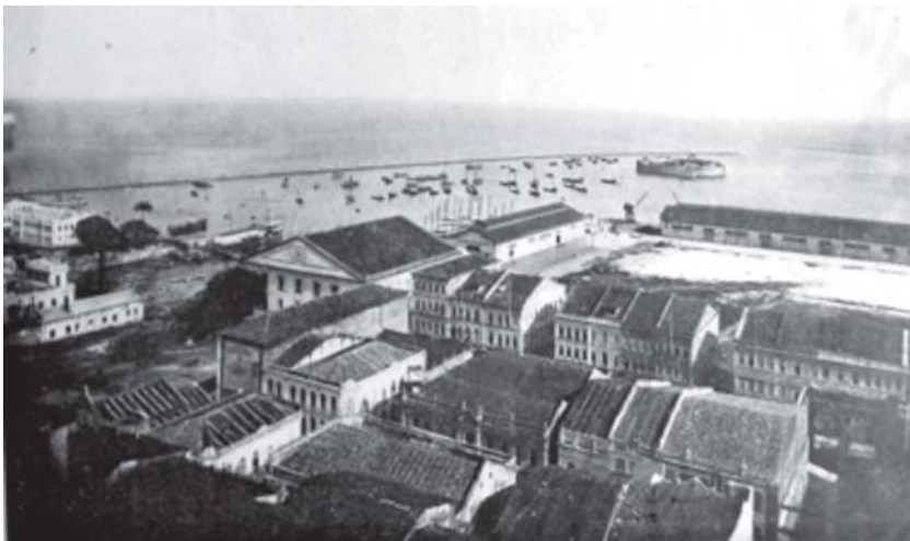
Figura 2 -Vista parcial do porto e do Comércio em 1917
