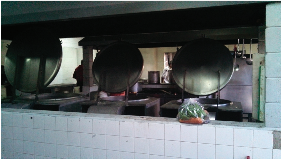
Figura 8. Sector cocina. Complejo Penitenciario San Martín, 2014.
