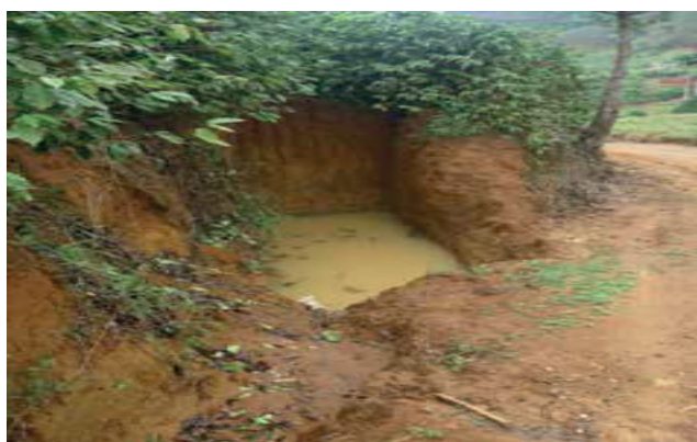
Figura 3. Caixa seca na estrada de acesso à lavoura
