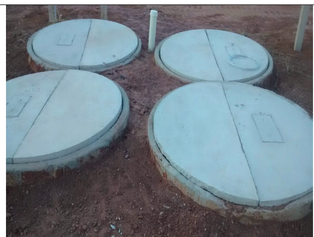
Cisterna – sistema Cisterna-Calçada
