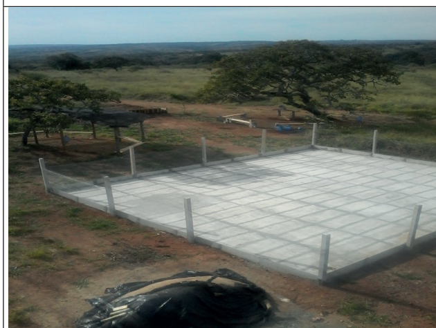
Calçada – sistema cisterna-Calçada
